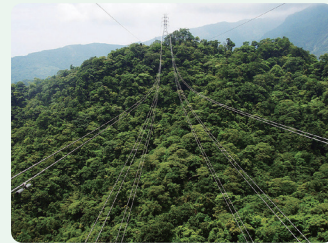
▼ 台電玉里~豐濱輸電線路工程
